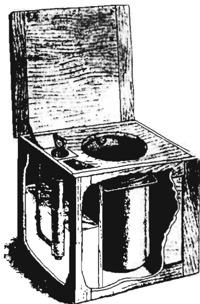
Retrete portátil de agua con bomba y cubo de cobre, año 1882.
