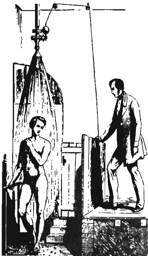
El baño de lluvia consistía en un depósito de agua fría colgado en el techo, con una válvula que era accionada por el médico mediante una cuerda.
